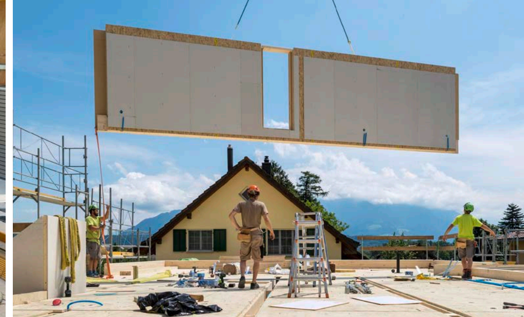
Ein vorgefertigtes Haus ist zwar schnell erstellt, aber ohne Präzisionsarbeit geht es auf der Baustelle nicht: Das Arbeiterteam von Alpiger Holzbau AG muss die tonnenschweren Elemente sorgsam einjustieren.
