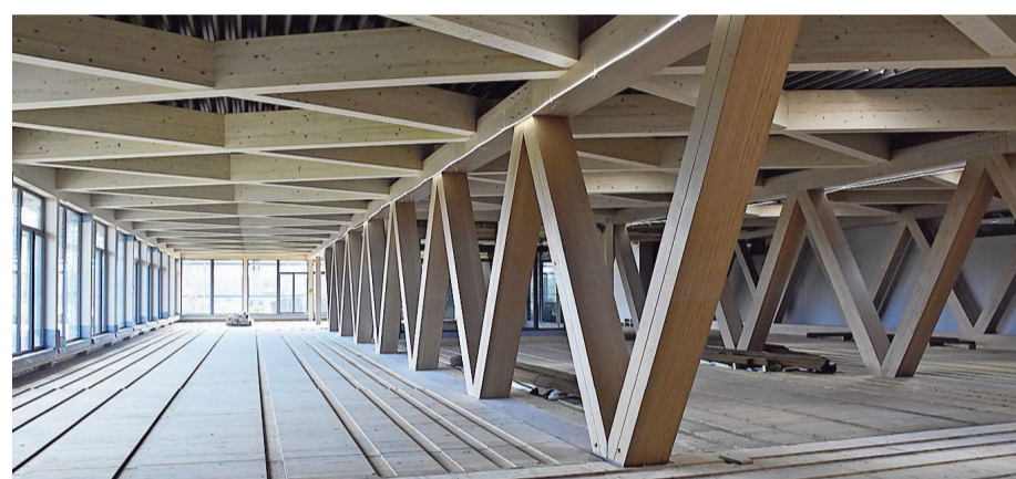
Oben: Modell der Werke 5, 6 und 7 (Werk 5 bestehend, längs im Vordergrund, Werk 6/7 quer im Hintergrund). Unten: Im obersten Stock des Erweiterungsbaus werden Büros eingerichtet.
