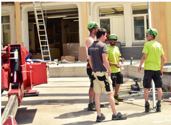
Benjamin Nussbaum auf einer Baustelle im Gespräch mit Alpiger-Zimmermännern.
