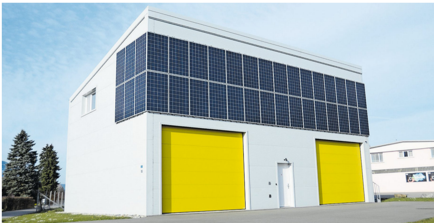
Vor etwas mehr als einem Jahr hat Bächli Power das Gewerbegebäude an der Nordstrasse in Haag bezogen.
