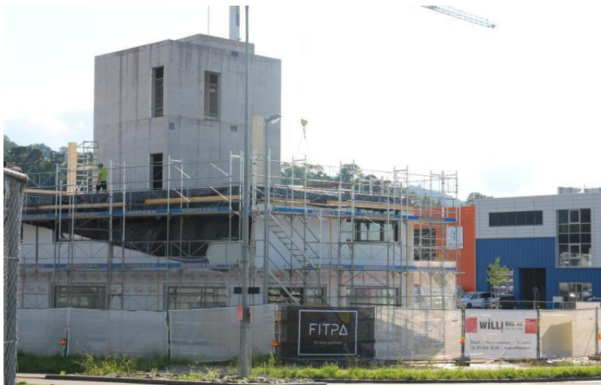
Derzeit wird fleissig am innovativen Holzbau gebaut.
